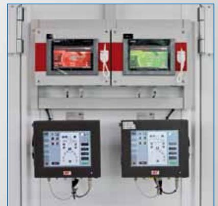
Das Steuerpult einer Doppelkabine. An den Monitoren werden die jeweiligen Trockenvorgänge programmiert.
